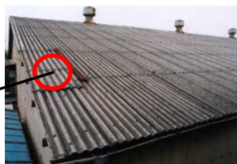
波形スレートの屋根施工例
